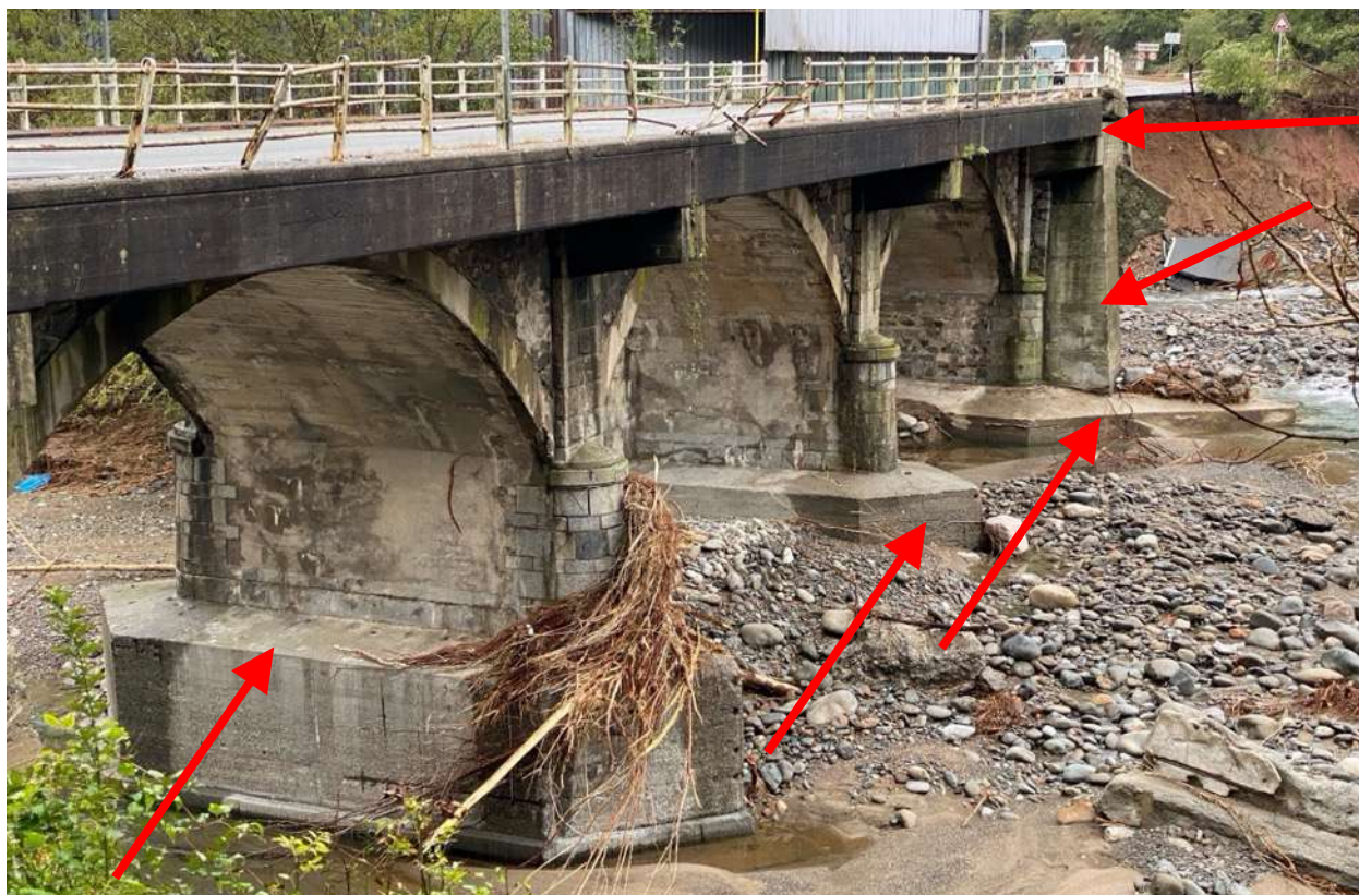
Indicazione delle opere di consolidamento realizzate a seguito dell'alluvione del 1968
