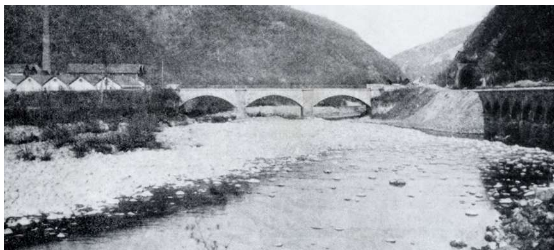
Ponte di Crevacuore e Galleria Squissone. Il ponte e la ferrovia ormai non ci sono più
