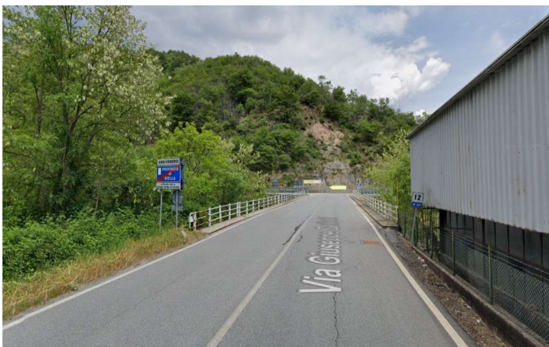
Vista del tratto di viabilità prima del dissesto
