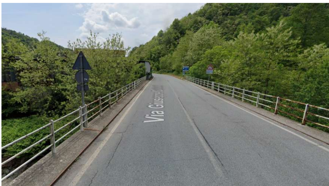
Vista del tratto di viabilità prima del dissesto
