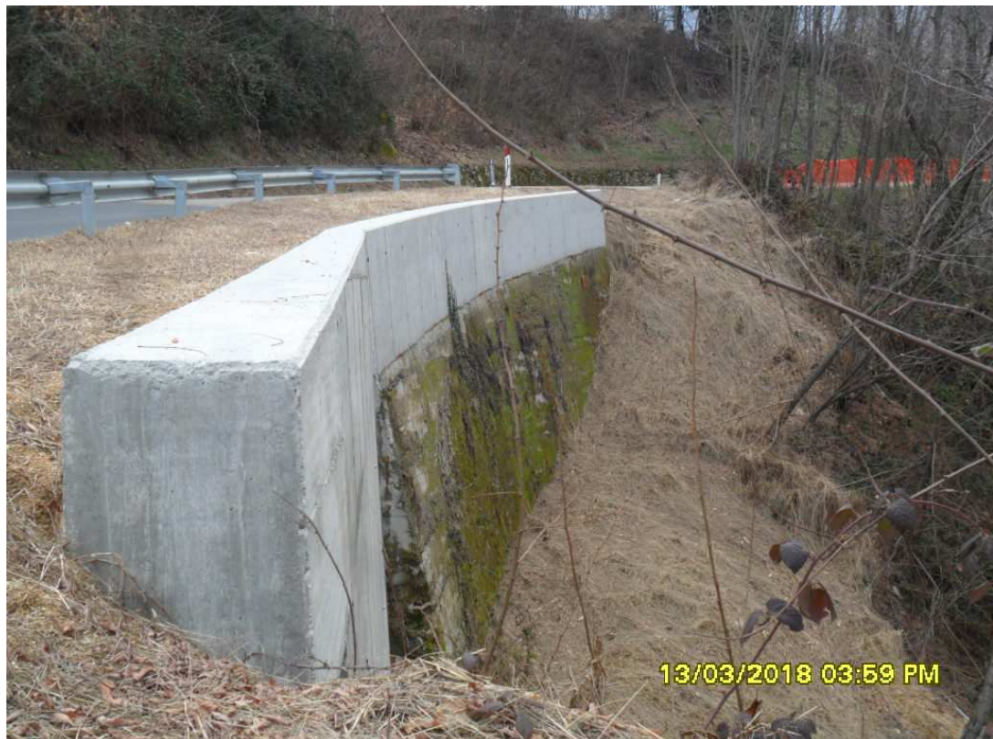
Foto 12: particolare intervento eseguito in seguito ad evento alluvionale 2014 al km 2+800 (punto di ripresa dir. Trivero)
